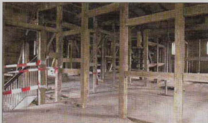
Ein Blick in das Dachgeschoss: Auch von diesem regelrechten Fachwerk-Gewirr soll so viel wie möglich erhalten werden.
