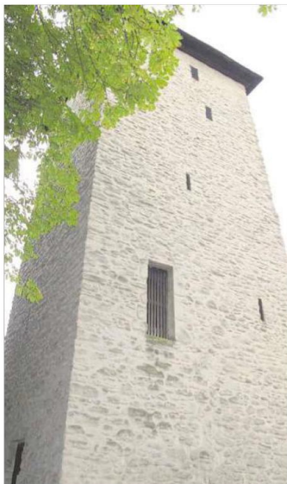
Mächtig ragt der Poenigeturm in die Höhe. Dabei werden die Mauern immer dünner. So nimmt die Grundfläche von 9 Quadratmeter am Boden auf 16 Quadratmeter oben zu.
